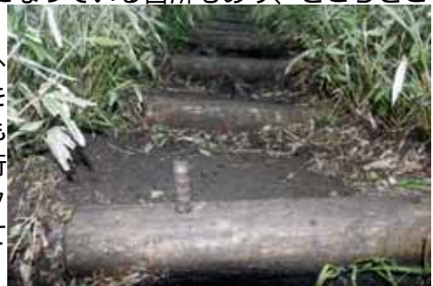
丸木階段の鉄骨
